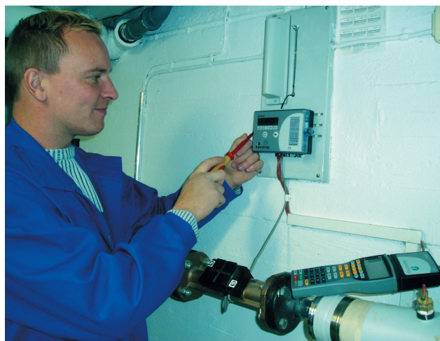
Asentaja Janne Vihervuori: ”Radiolaitteiden asentaminen Kamstrup-kaukolämpömittareihin voidaan tehdä ilman erikoistyökaluja”.
